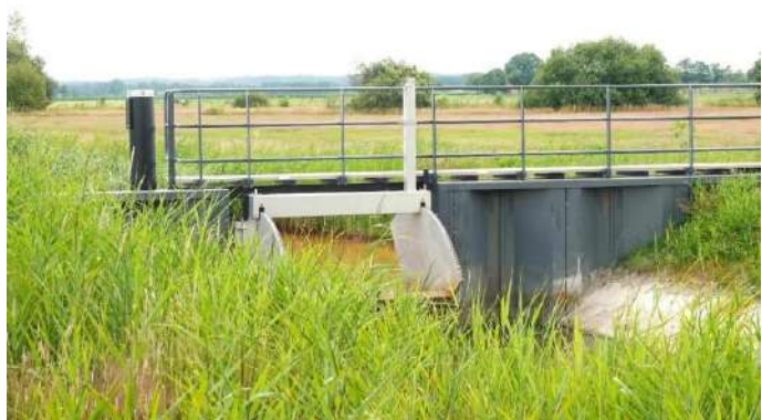
Nieuwe stuw ter plaatse van de vroegere uitmonding van de Oude Voorster Beek in de Zilvense Broekbeek
